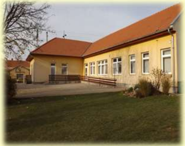
az óvoda épülete /Felsődobsza/
